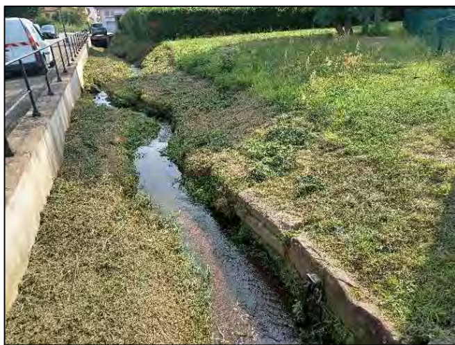
Travaux de Fauche à Boersch
