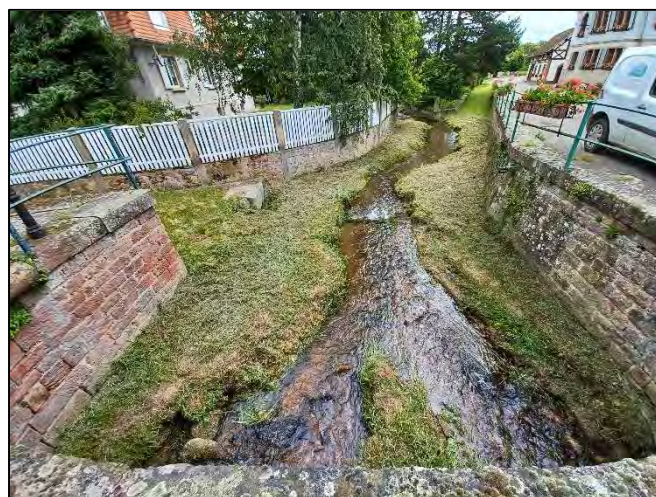
Travaux de Fauche à Bourgheim
