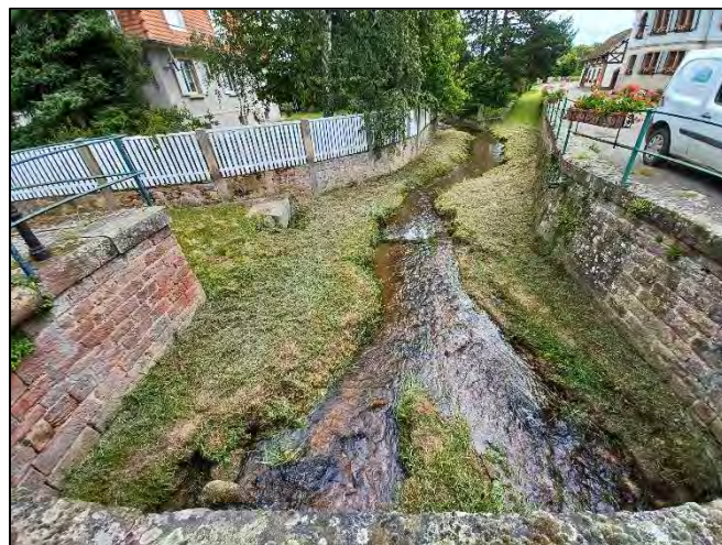
Travaux de Fauche à Bourgheim
