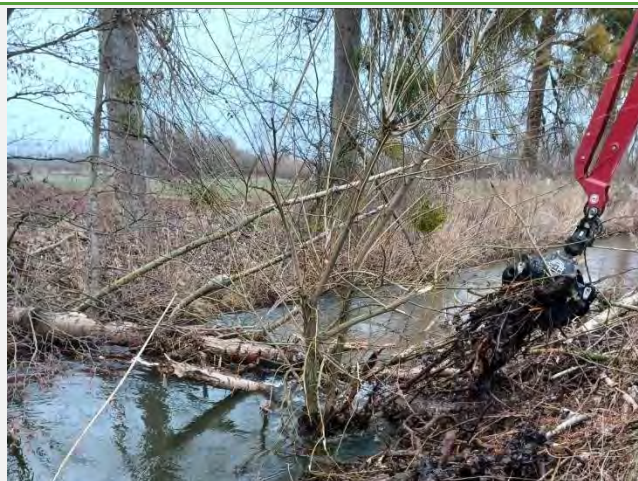
Février : Surveillance des ouvrages, gestion des embâcles, entretien des boisements de berge et travaux pluriannuels. Dégagement d'un embâcle sur l'Andlau à Westhouse
