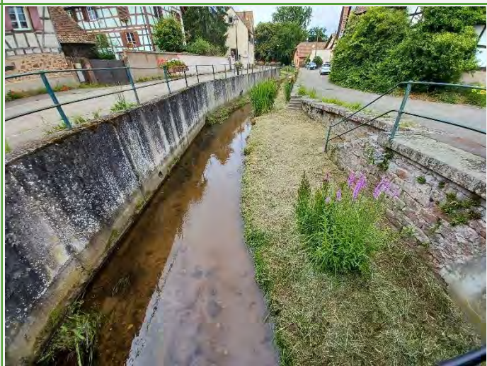
Juin : Surveillance des ouvrages, Gestion d'embâcles et travaux de fauche de printemps Fauche de la Kirneck à Bourghheim
