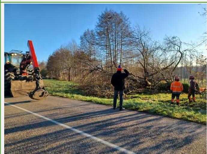
Novembre : Travaux d'entretien des boisements de berge Abattage Sanitaire le long du Canal de l'Ehn à Obernai
