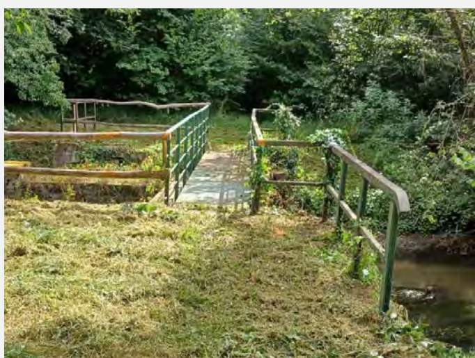
Août : Gestion des ouvrages / Travaux de fauche, dégagements d'embâcles et suivi des étiages Entretien du pont de la Holtzgass à Hindisheim
