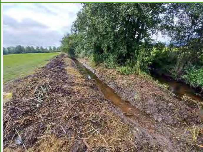
Septembre : Entretien des lits d'écoulements / Travaux de fauche, suivi des étiages Décapage du Koenigsgraben à Meistratzheim le 09/09
