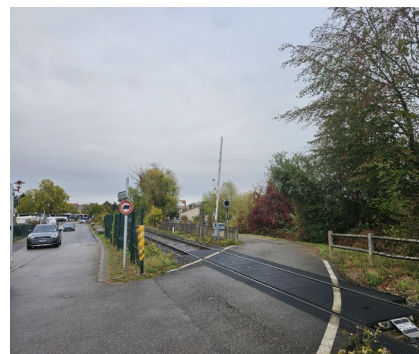
Rue Poincaré, passage à niveau dont la suppression a été programmée
