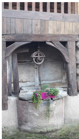
Puits rue de la Chapelle à Obernai – non identifié parmi les éléments de petit patrimoine protégés sur le règlement graphique consulté.
