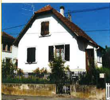
▲ maison, rue de la 1ère DFL
