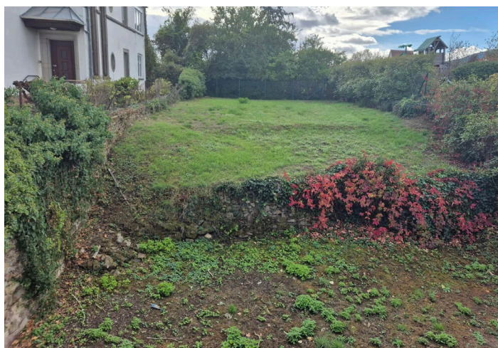
Débouché de l'ER O.12 , vestiges de l'enceinte extérieure
