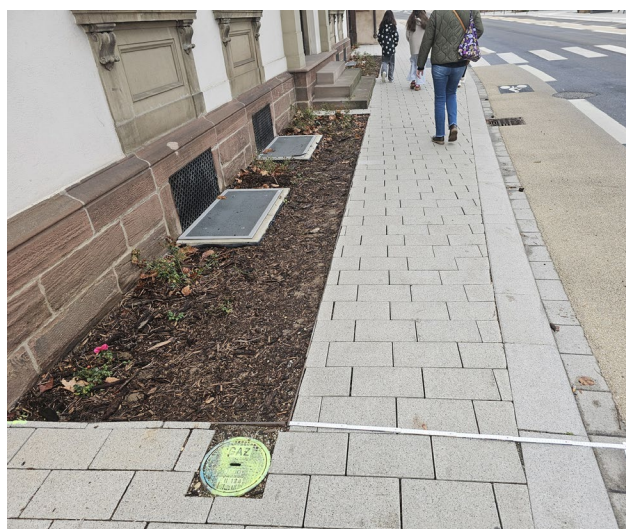
Trottoir aménagé en pavage au droit du 17 rue du Gal Gouraud – 10/2026
