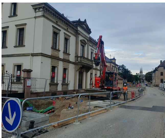
Travaux d'aménagement rue du Gal Gouraud menés en 2025
